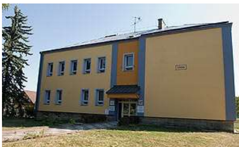
Mateřská škola Oldřichovice č. p. 210
