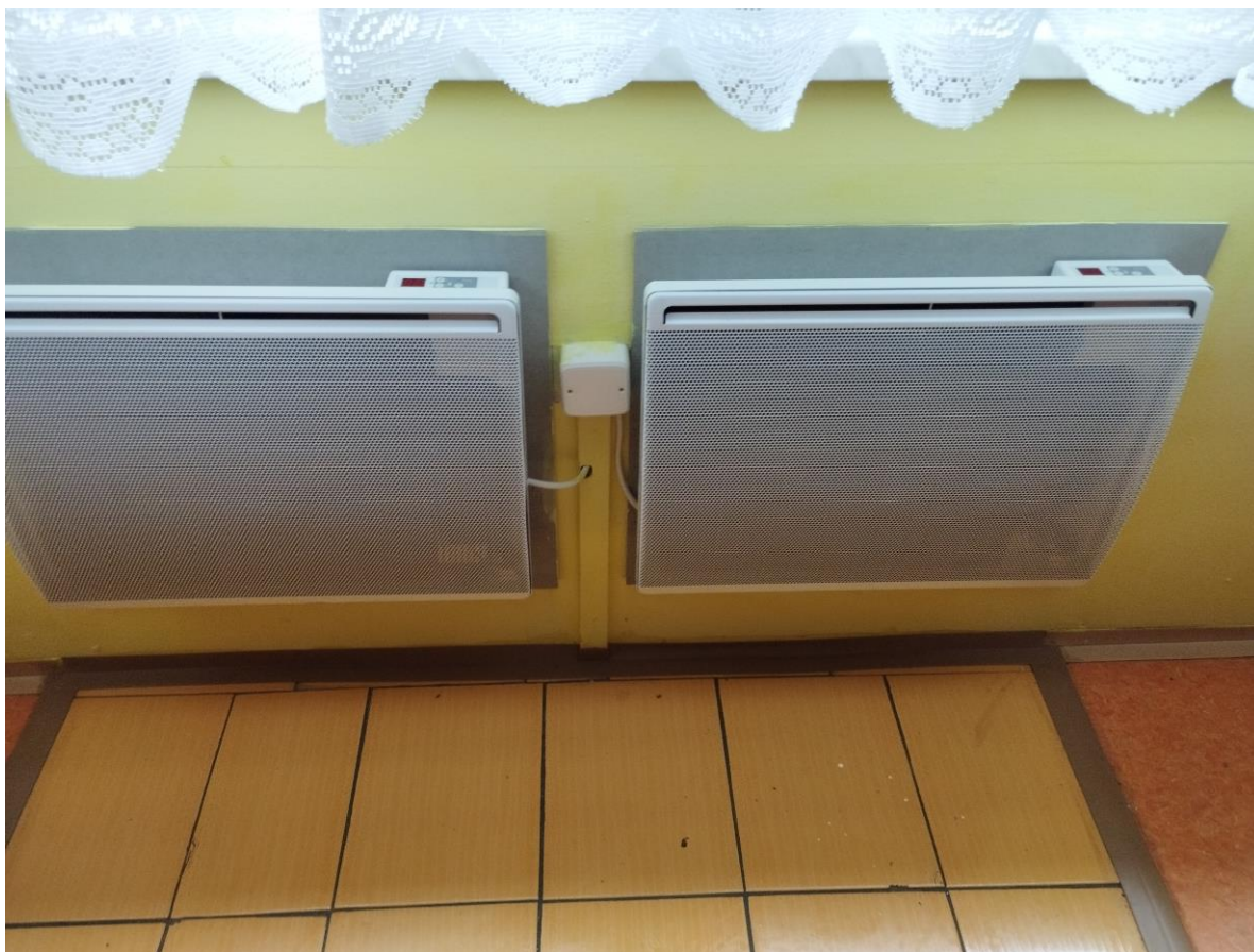
Přímotopy místo akumulčních kamen
