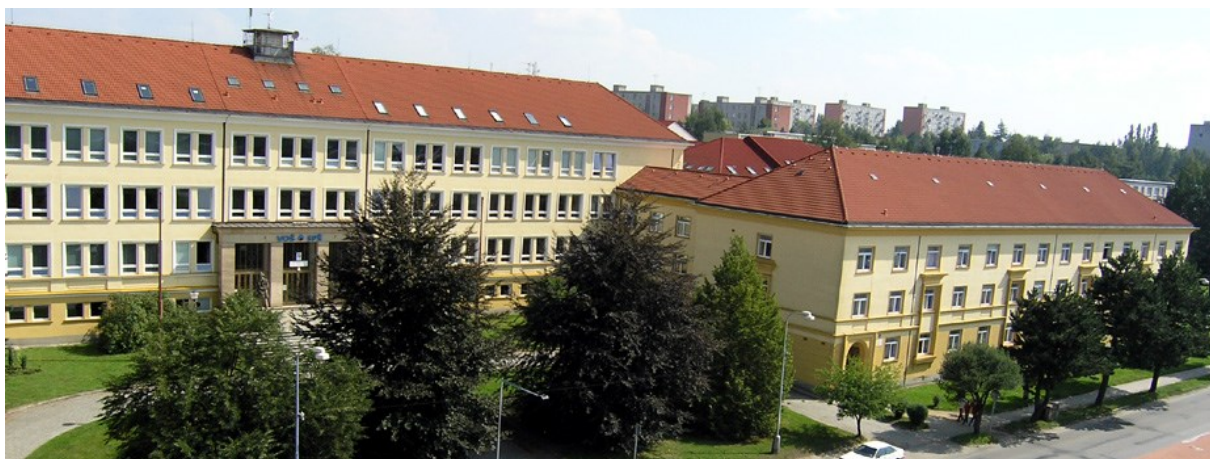
Hlavní budova školy na ulici Studentská s přilehlým domovem mládeže
