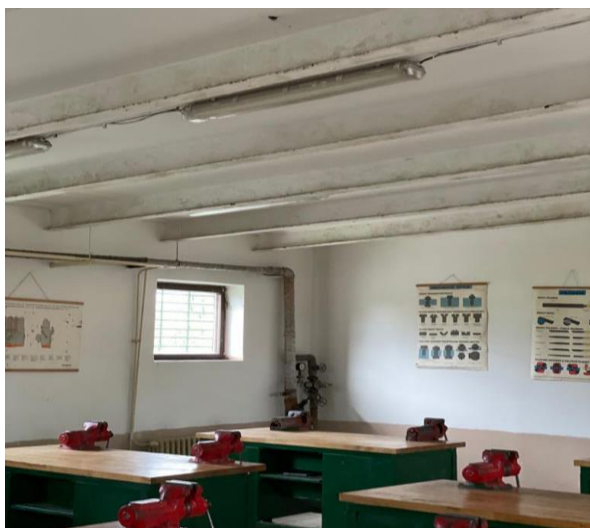
Zateplení stropu učebny OV pro ruční opracování kovů před opravou
