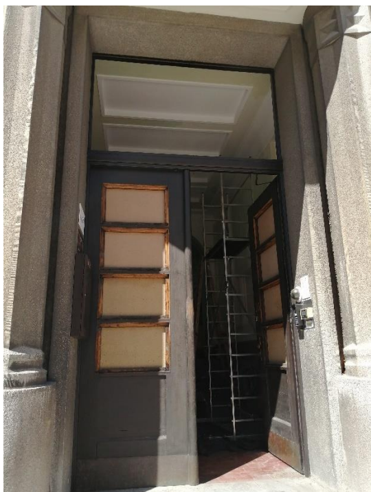
Vchodové dveře před rekonstrukcí, 2020
