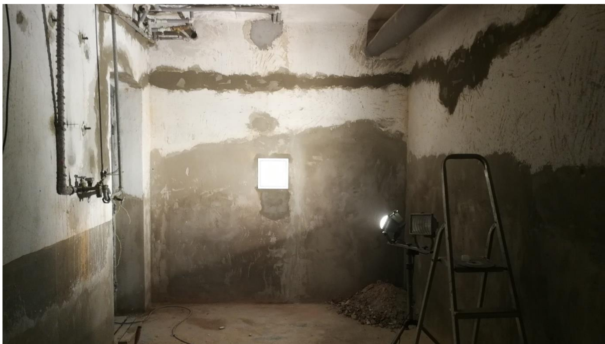
Sklad čistících prostředků před rekonstrukcí, 2019
