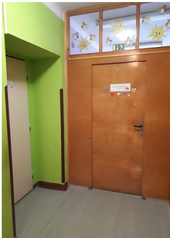
Školní družina – chodba před rekonstrukcí
