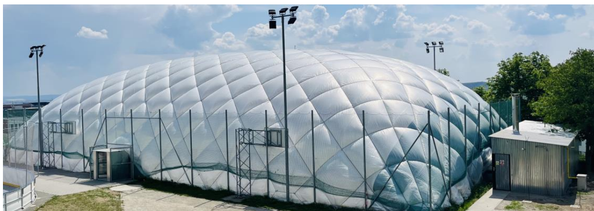
Obr 17: Nově vybudovaná přetlaková hala při ZŠ Kamínky
