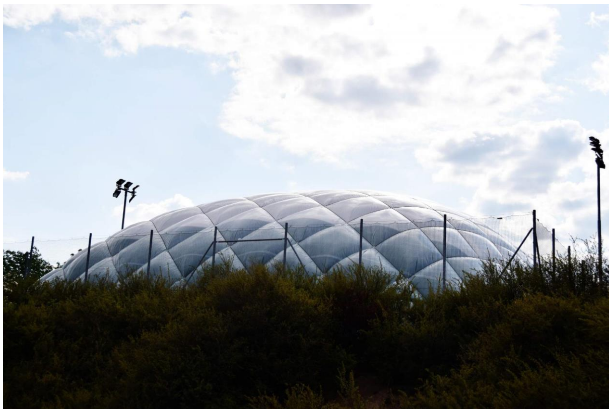
Obr 18: Nově vybudovaná přetlaková hala při ZŠ Kamínky
