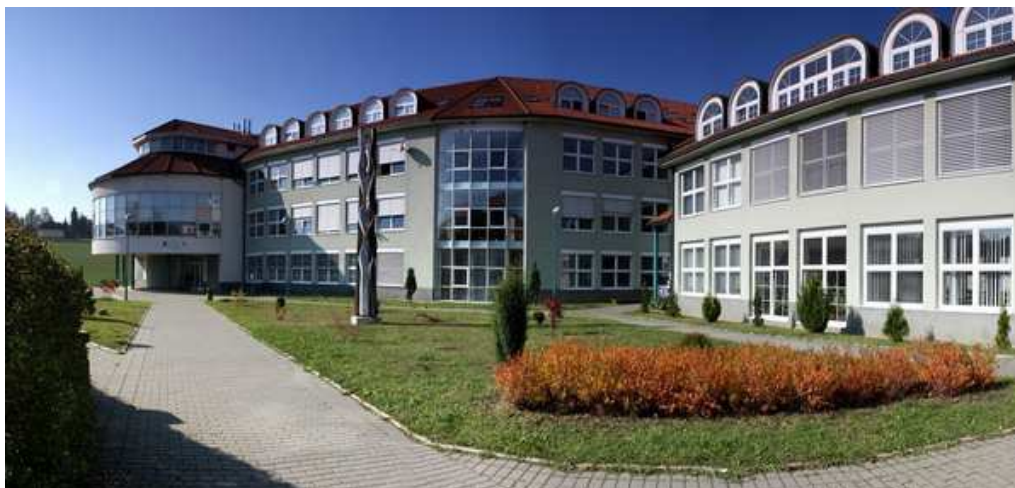
Budova školy – průčelí
