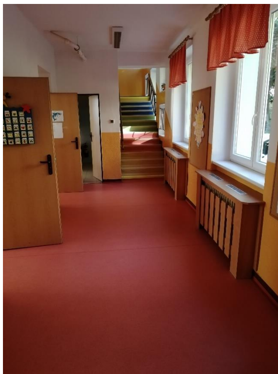
Nové podlahové krytiny + malování v MŠ Žižkova
