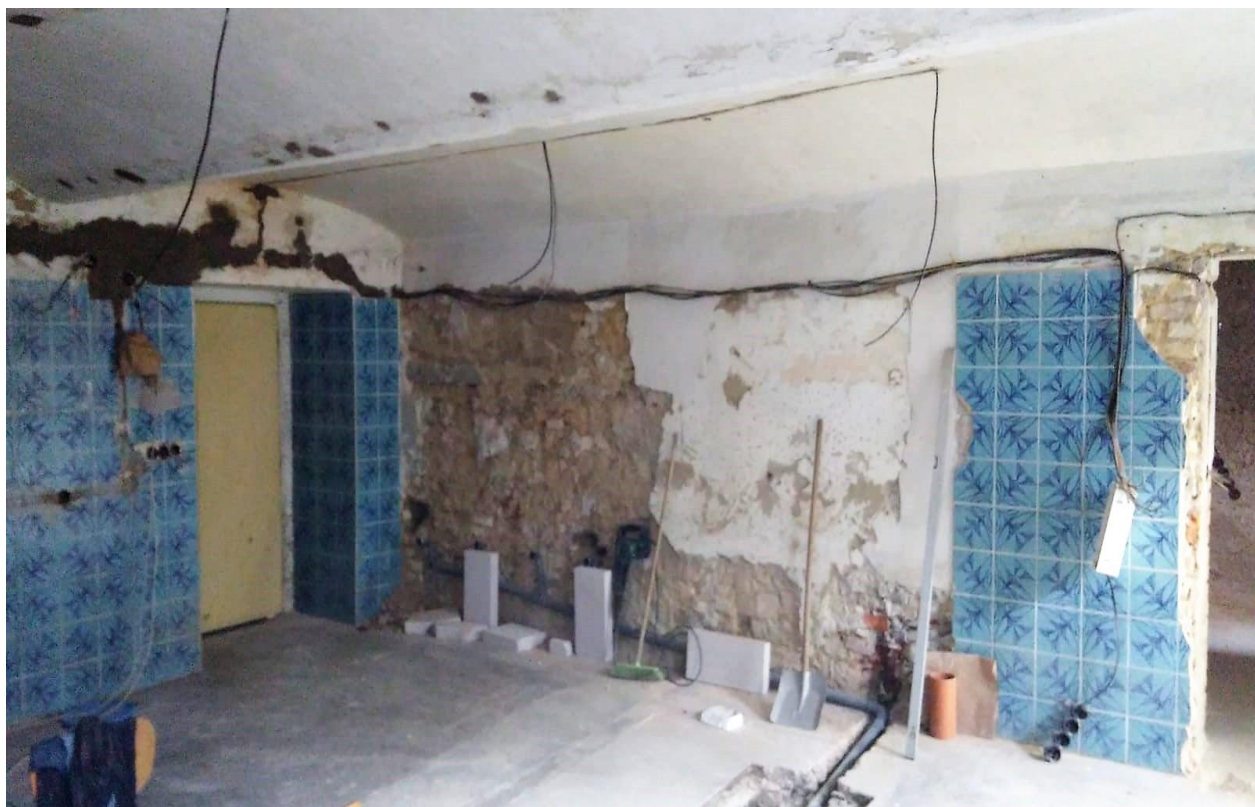
Původně sklepní prostor k ukládání již nepotřebných věcí
