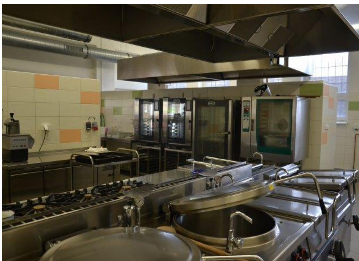
V období července až listopadu 2017 byla zrekonstruována školní jídelna s kuchyní.
