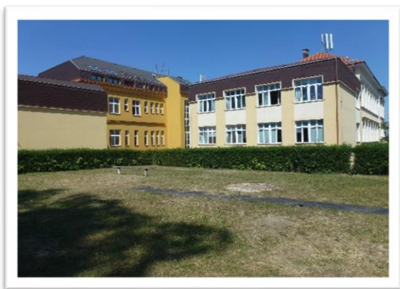
Zahrada před vybudováním záhonů
