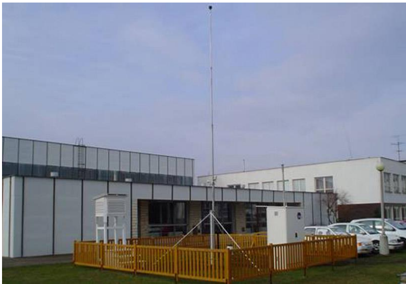
Fotografie č. 5 – Stanice imisního monitoringu a meteorologie
