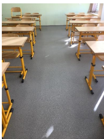
Podlaha v učebně Č1 – stav po renovaci
