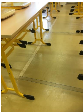
Podlaha v učebně Č1 – původní stav
